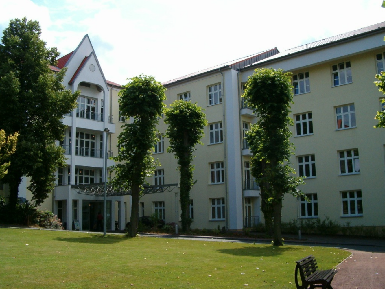
Abbildung: Haupteingang Evangelisches Krankenhaus "Gottesfriede" Woltersdorf
